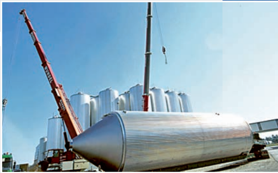
Aufstellung von Zyl.-Kon. Gär- und Lagertanks Installation of zyl.-kon. Fermentation and storage tanks
