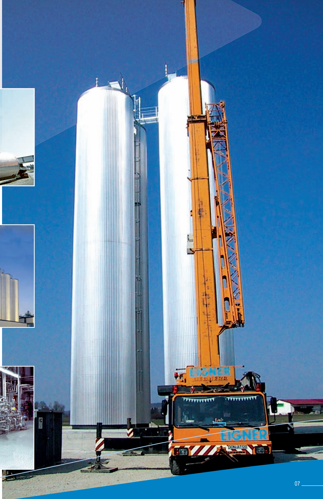
Aufstellung von Zyl.-Kon. Gär- und Lagertanks Installation of zyl.-kon. Fermentation and storage tanks
