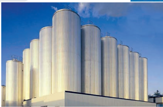
Zyl.-Kon. Gär- und Lagertankanlage Zyl.-kon. Fermentation and storage tank system
